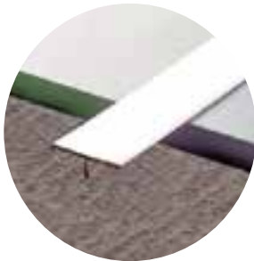
Instalación del perfil "T"
